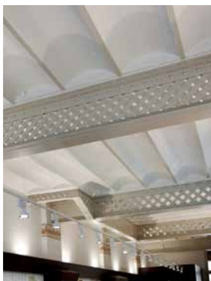
El techo original también se ha conservado en este proyecto
