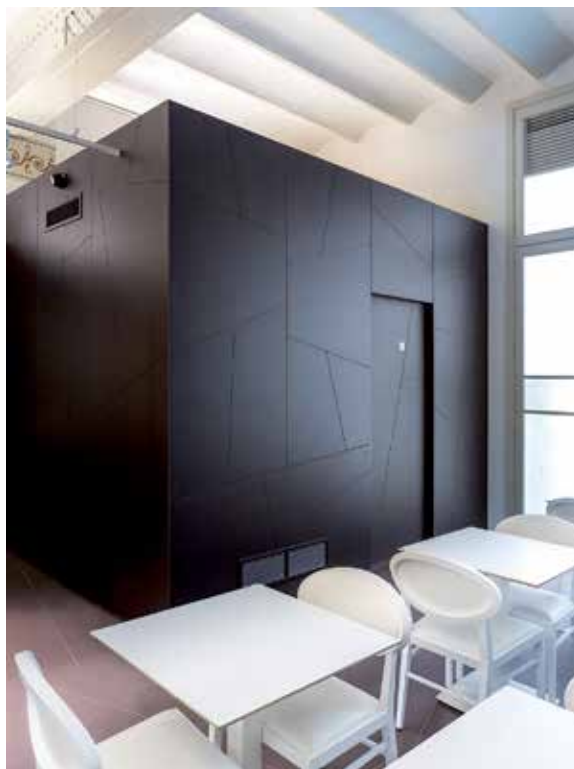
El cubículo de los servicios públicos se recubre con el mismo material que el utilizado en el pavimento
